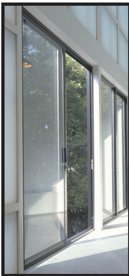
'Piece of cake' habitation à Den Haag. Façade constituée d'une ossature bois et de caissons vitrés. La lame d'air remplie par des plastics d'emballage ; des films à bulles ordinaires du catalogue Overtoom. Architecte Victor Mani - Materia
