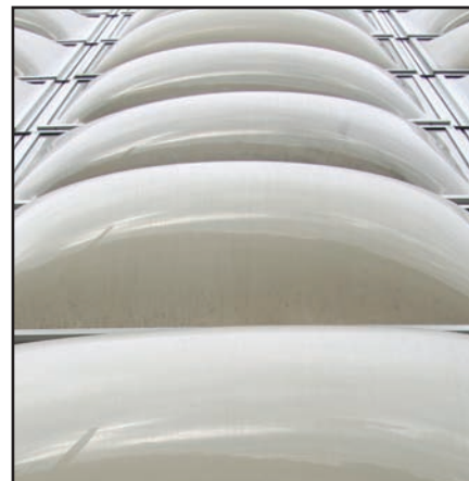
Stade de Bâle (CH), Herzog & de Meuron. Façade réalisée à l'aide de coupoles transparentes et translucides en polycarbonate.
