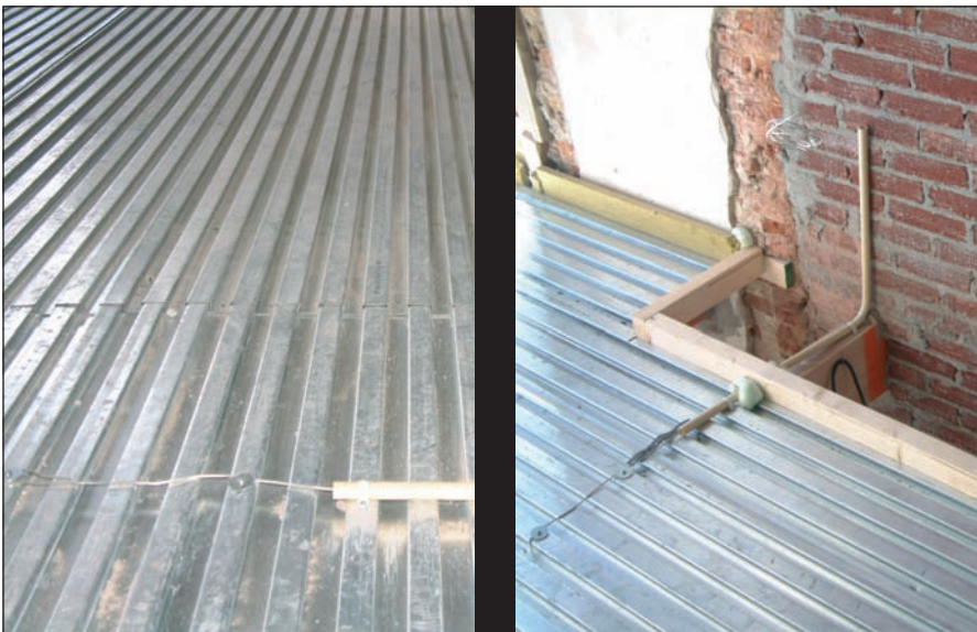
Une chape liée au ciment peut être coulée directement sur les tôles profilées servant de coffrage collaborant. Sur le périmètre, il est utile de prévoir un matériau susceptible de reprendre des retraites et tassements.
