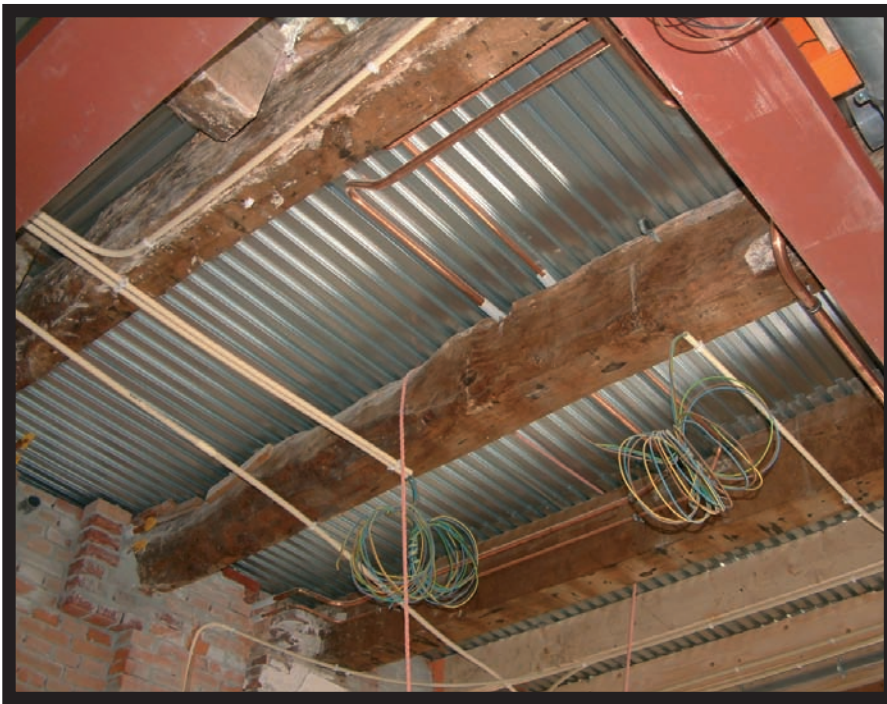
Grâce à son système partiellement autoporteur, ce système de plancher-dalle permet de remplacer les planchers bois déficients ou affaiblis
