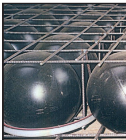
Les « boules » sont retenues entre deux lits d'armature. Ces résilles d'armatures boules incorporées peuvent être préfabriquées en usine, livrées sur chantier et positionnées sur base d'un schéma prédéfini sur les pré-dalles.
