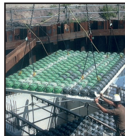
Les éléments préfabriqués se composent d'une pré-dalle, d'armatures et de ballons sont livrés sur chantier. Seule l'opération finale de mise en place et de bétonnage devant être encore réalisée.
