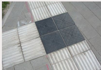
Ligne guide à l'aide de dalles striées et dalles d'information noires. Photo : Voetgangersbeweging VZW.
