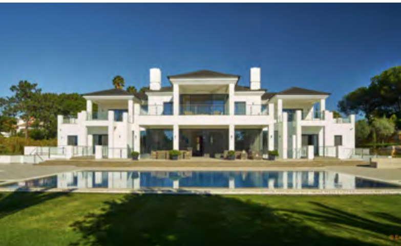
EeStairs + Stewart Seaton Arquitecto, Quinta do Lago [PT] Copyright : EeStairs
