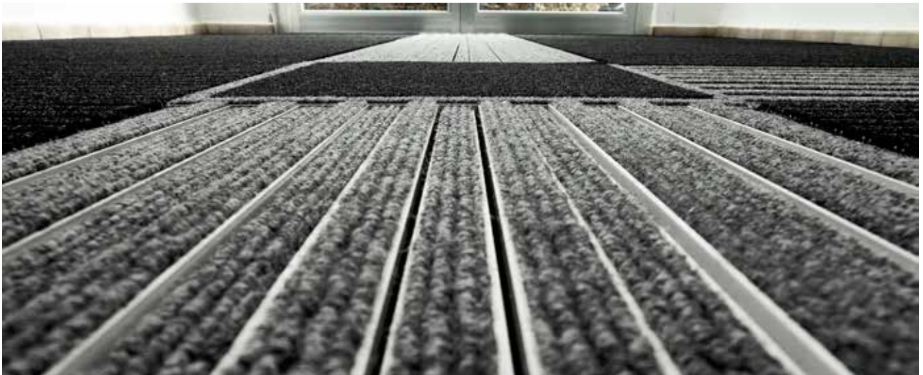
Parallel aan de looprichting liggende aluminium profielen met verschillende hoogtes zijn zowel met de schoenzolen als met een ondersteunende stok te herkennen.
