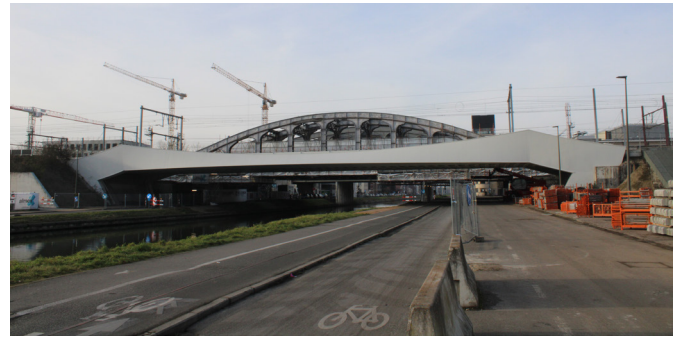
Les ponts Vierendeel, en partie derrière le nouveau pont ferroviaire
