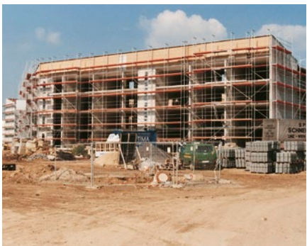
↑ Bij het bouwen van een appartementencomplex was de keus voor Faay isolatiewanden snel gemaakt.
